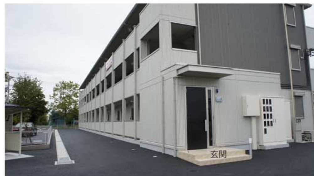
北側外観 玄関ホールに防犯カメラ+セーフティアゲインルームは、 非常時には警備会社と internet により直結監視
